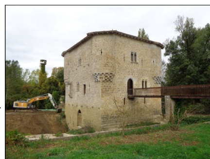
Travaux autour du moulin fortifié de Bagas
