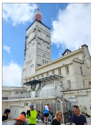
L'antenne TDF du Mont Ventoux
