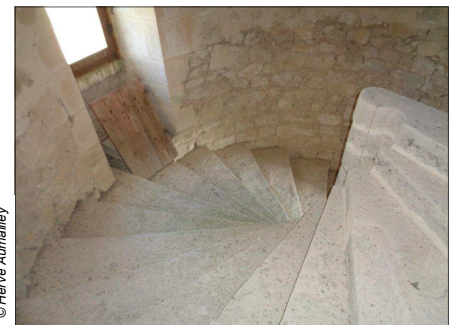
Le 27/07 - Bel escalier intérieur (Sauvagnac)
