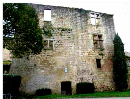
Le 15/02 - Extérieur du château de Podensac
