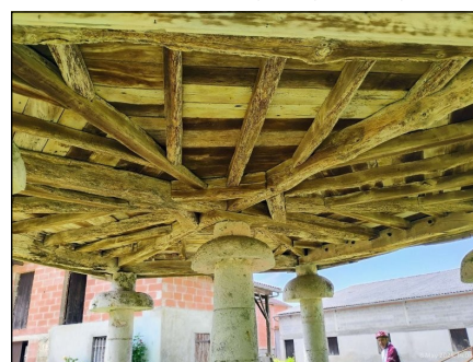
Charpente sous le grenier à grains
