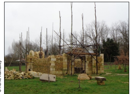
Le 05/02 - La chapelle en cours de construction
