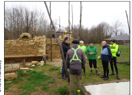
Le 05/02 - Commentaires du chef de chantier
