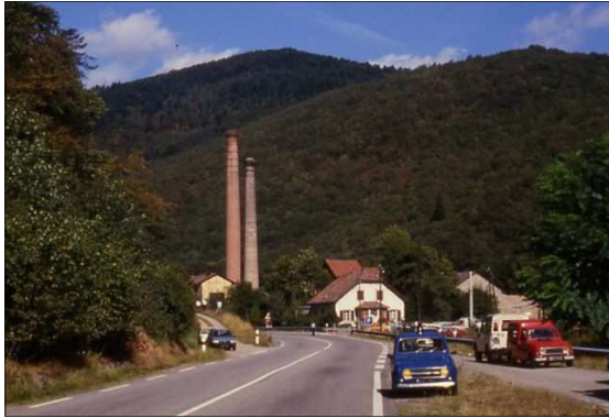
Les cheminées qui ne voulaient pas sauter !
